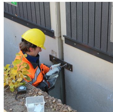
Kuva 7. Runkokaivojen sidonta toisiinsa
