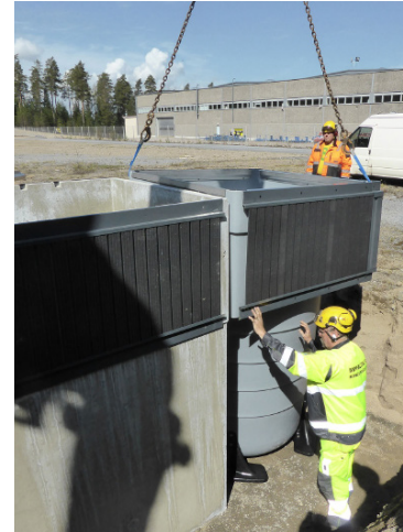
Kuva 8. Säiliöiden nosto kuoppaan
