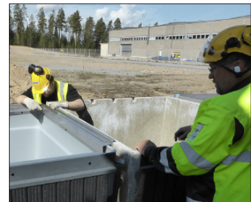
Kuva 9. Muovikaivon kiinnitys betonikaivoon
